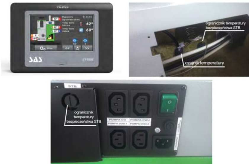
Rysunek 15. Lokalizacja ogranicznika temperatury bezpieczeństwa STB oraz czujnika temperatury
