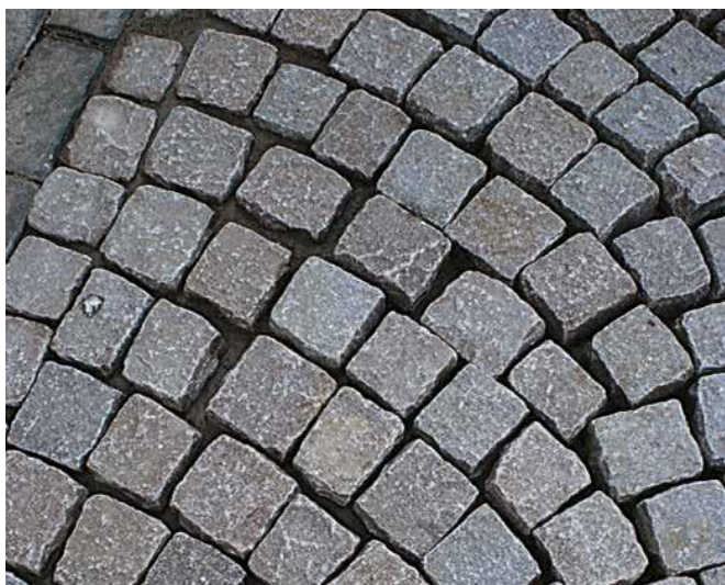
1 Nawierzchnia z kamiennej kostki brukowej o różnej szerokości szczelin spoinowych.
