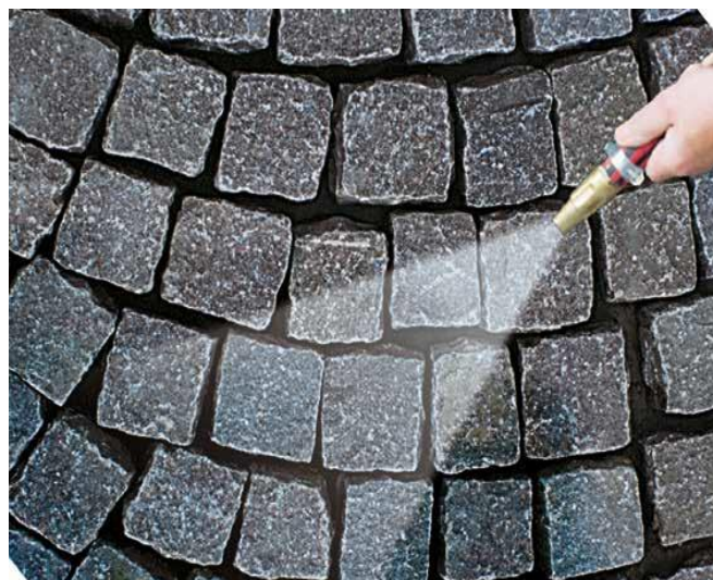
2 Nawilżona i oczyszczona nawierzchnia przygotowana do spoinowania.
