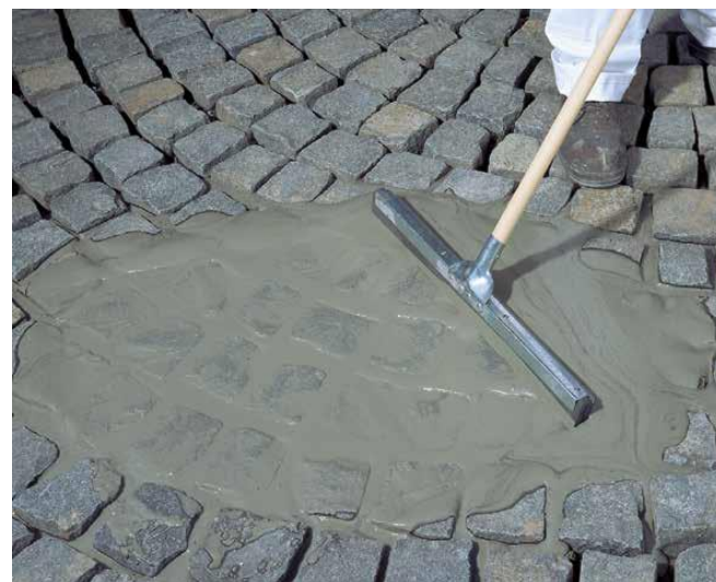
6 Wypełnienie spoin samozagęszczającą się zaprawą Sopro PFM.
